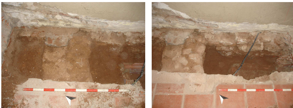
Vista en detall del mur u.e. 204 i de com se li recolza la banquetta de fonamentació u.e. 207 del mur actual de l'edifici.
