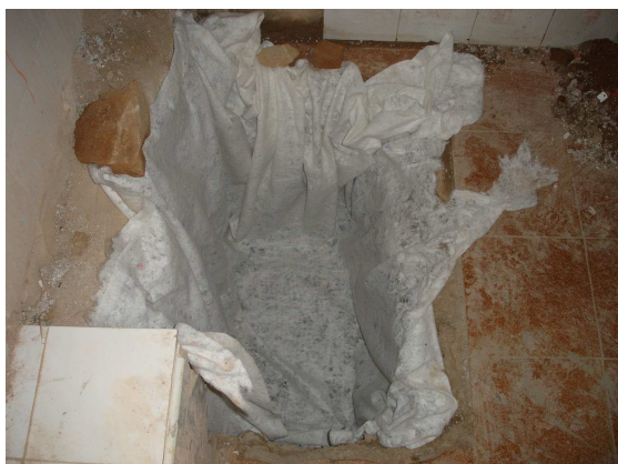
Vista del Sondeig 4 protegit amb geotèxtil i reomplert amb formigó.
