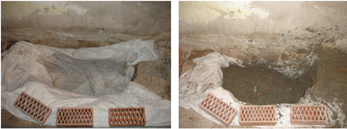
Vista del Sondeig 3 protegit amb geotèxtil i reomplert amb formigó.
