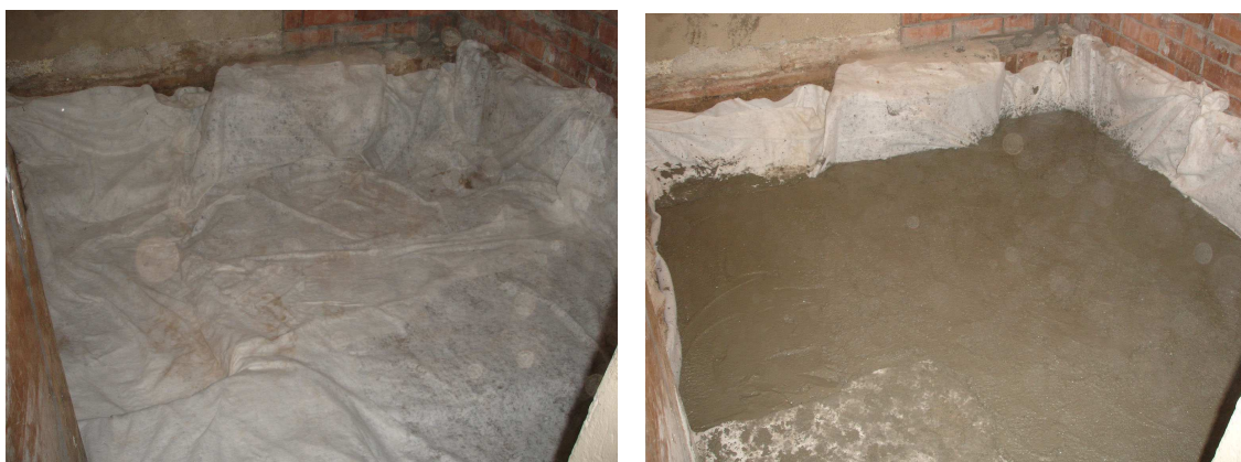
Vista del Sondeig 1 protegit amb geotèxtil i reomplert amb formigó.
