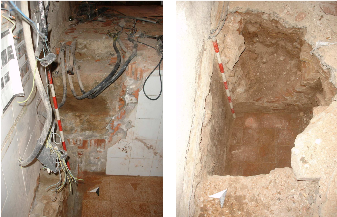
Vista de l'escala u.e. 302 i del paviment u.e. 312 amb la paret u.e. 310.
