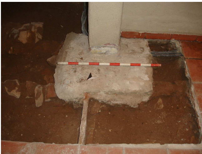
Vista de l'envà u.e. 107 tallat pel basament de formigó u.e. 106 del pilar.
