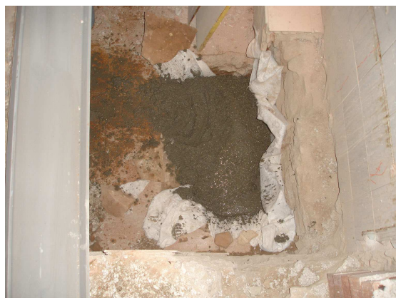
Vista del Sondeig 4 protegit amb geotèxtil i reomplert amb formigó.
