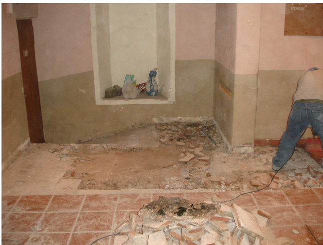
Vista de l'inici dels treballs d'excavació del Sondeig 1.
