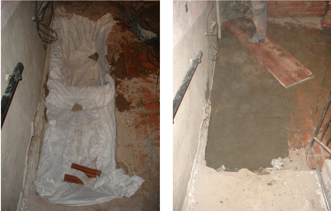
Vista del Sondeig 2 protegit amb geotèxtil i reomplert amb formigó.
