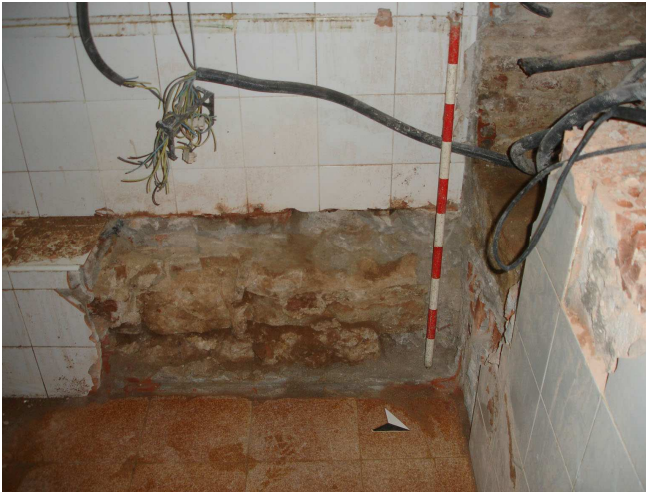
Vista de la banqueta de fonamentació u.e. 403 del mur actual de l'edifici, amb el sòcol u.e. 401 recolzat a sobre, per damunt del paviment u.e. 400.
