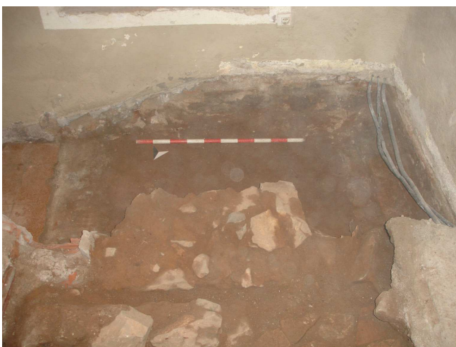
Vista de les banquetes de fonamentació dels murs actuals de l'edifici.
